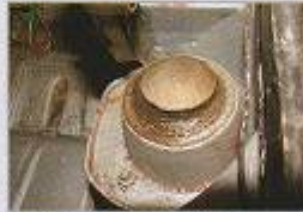
Unchristlich: Vorne sind die Domlager stark rostgefährdet
